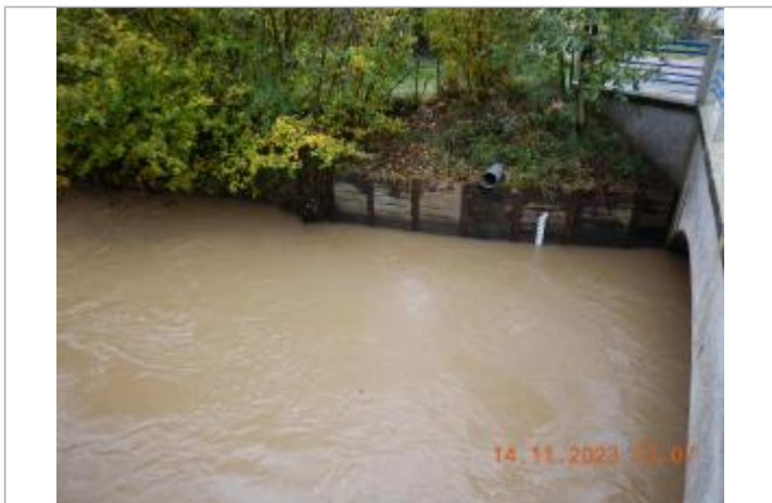
Debordement de cours d'eau
