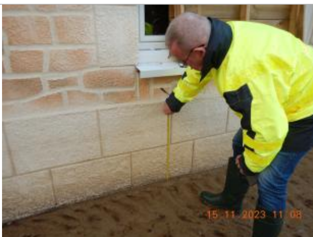
Debordement de cours d'eau
