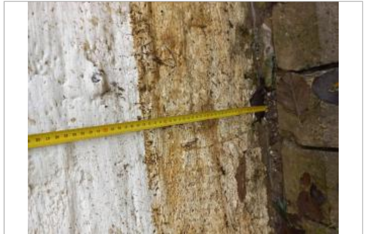
Debordement de cours d'eau
