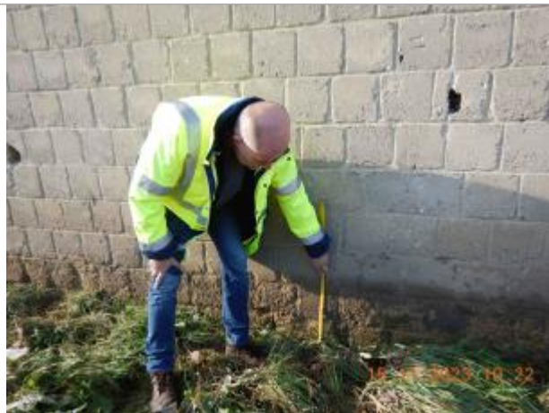
Debordement de cours d'eau
