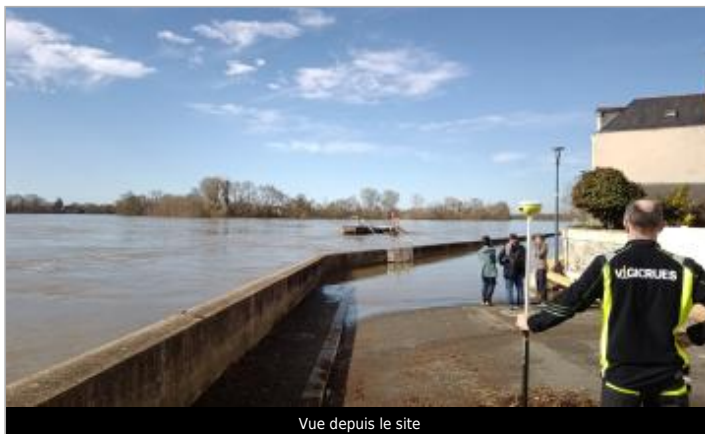
Vue depuis le site
