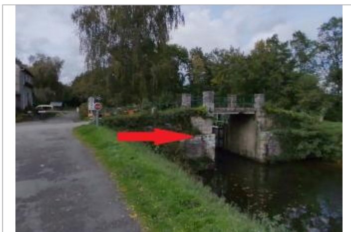
Aval écluse de la Née (Métairie) à Saint-Marcel
