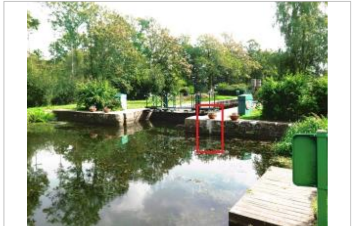
Ecluse de la Née (Métairie) amont à Saint-Marcel
