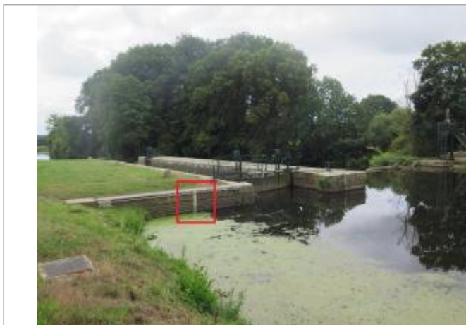
Ecluse de Grenouliere amont à Bréhan
