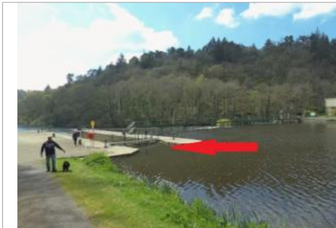
Amont de l'écluse de Kérouse à Languidic
