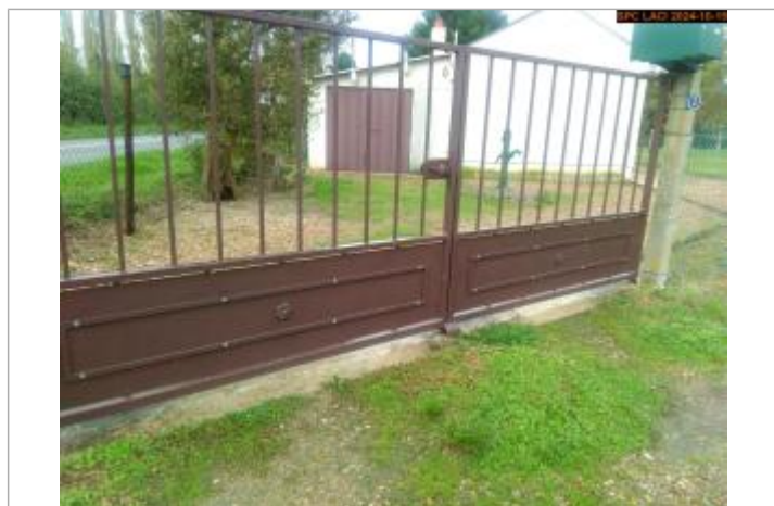
Vue sur la laisse d'inondation
