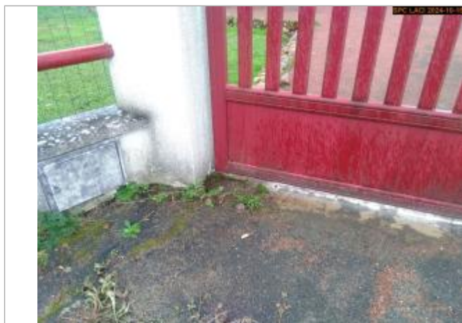
Vue sur la laisse d'inondation
