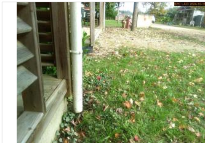
Vue sur la laisse d'inondation
