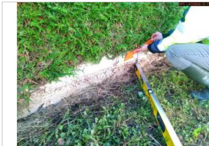
Vue sur la laisse d'inondation
