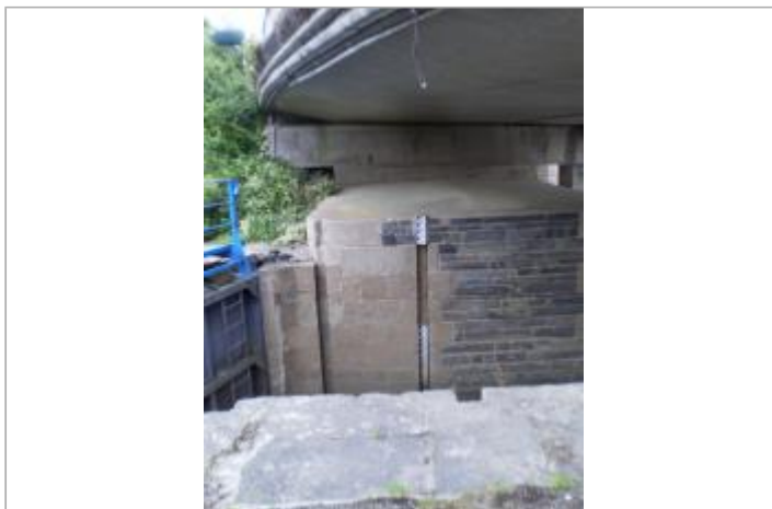
Aval de l'écluse de Guipry sous le pont de la RD 772
