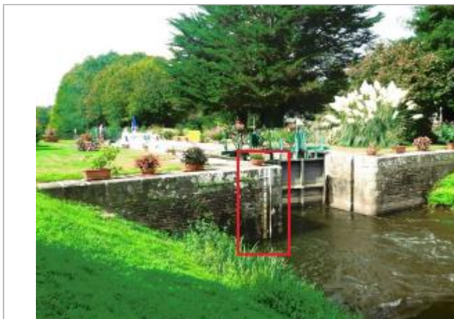
Ecluse de Foveno aval à Saint-Congard
