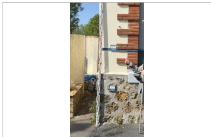
photo des repères
