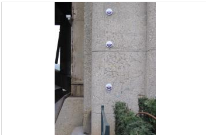
Repère n°5, Pont côté Marne
