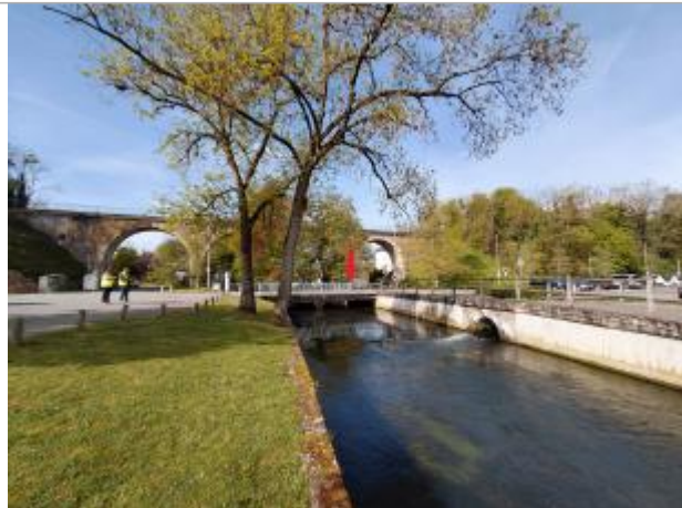
Vue depuis la piscine "Jean Bouin"
