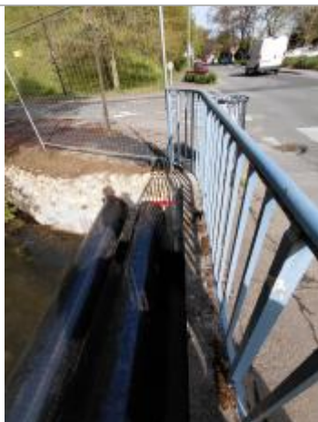
L'eau est montée à 1.61 m au niveau de l'échelle limnimétrique du pont.
