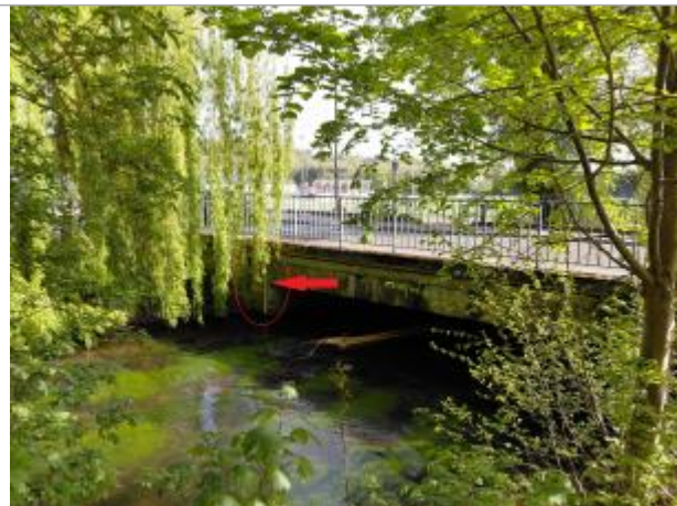
Vue depuis la sente sur la berge rive droite en amont du pont.
