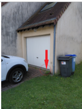
L'eau est montée jusqu'au pied de la porte du garage.
