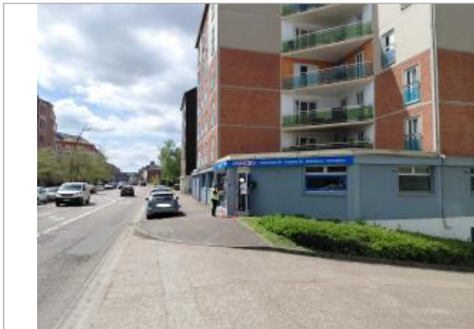
Vue depuis la rue Mendès France.
