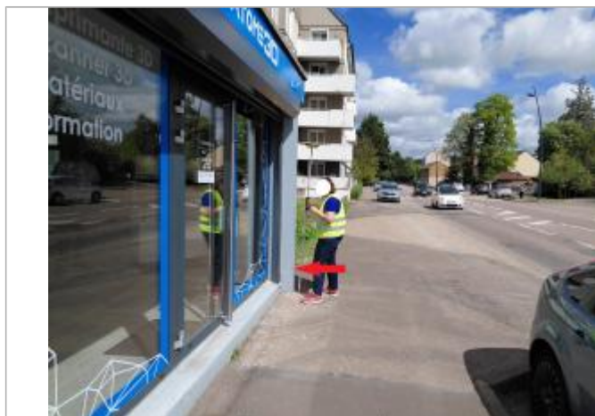
L'eau est montée au niveau du pilier de l'immeuble à environ 30 cm/sol.
