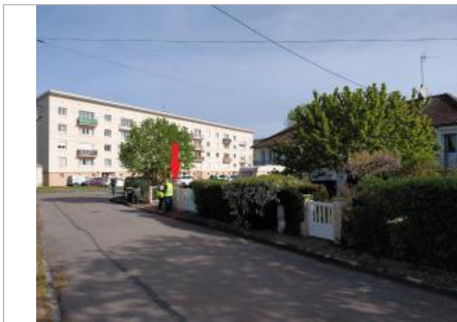
Vue depuis la rue De Coubertin.
