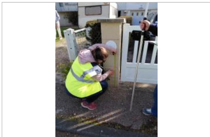
Laisse de crue à 48 cm/sol.
