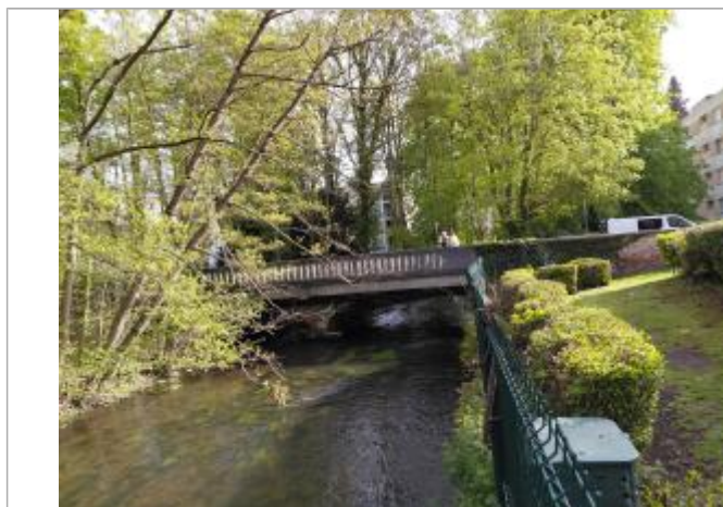
Vue du pont depuis la berge rive droite.
