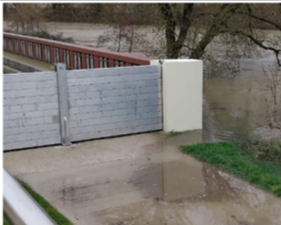
vue de la digue heuzé, au niveau des batardeaux de la maison écluisière
