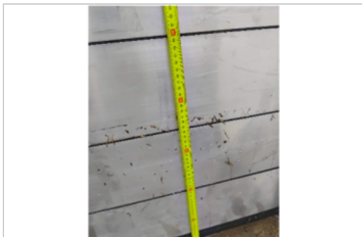
mesure de la laisse d'inondation sur le batardeau
