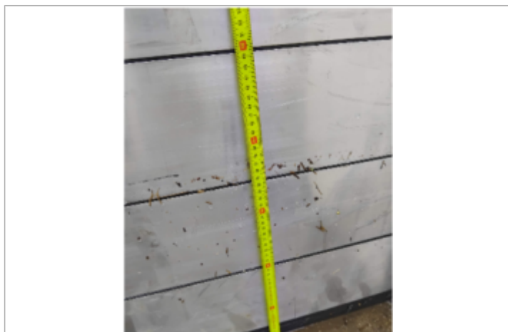
mesure de la laisse d'inondation sur le batardeau
