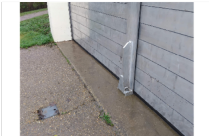
batardeau digue australie
