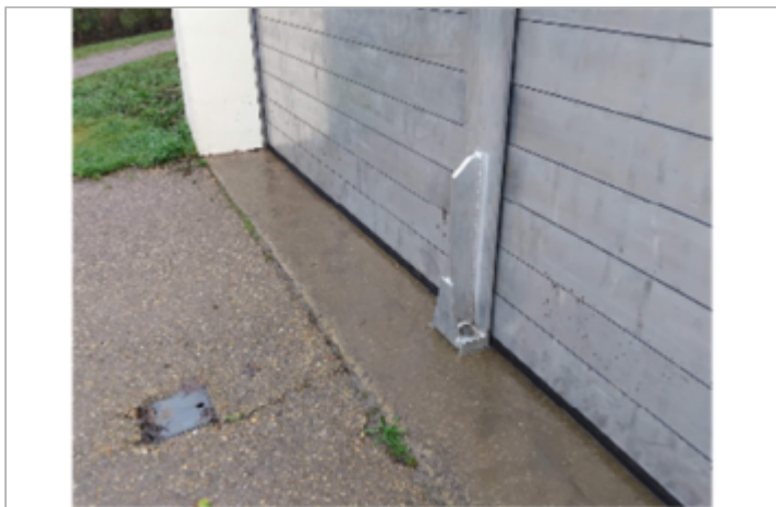
batardeau digue australie
