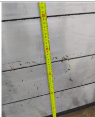
mesure de la laisse d'inondation sur le batardeau
