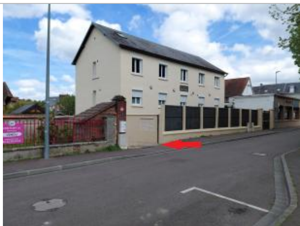
Laisse de crue au sol.
