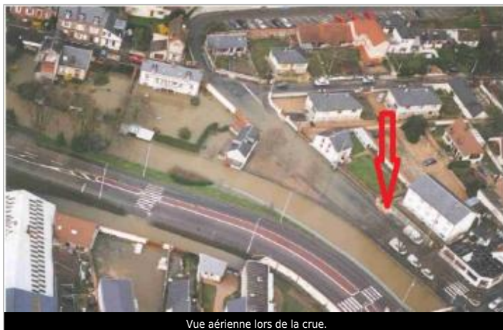
Vue aérienne lors de la crue.
