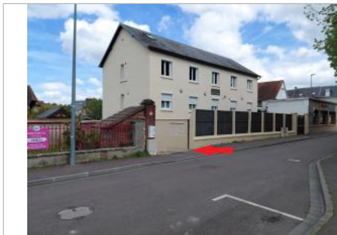
Laisse de crue au sol.
