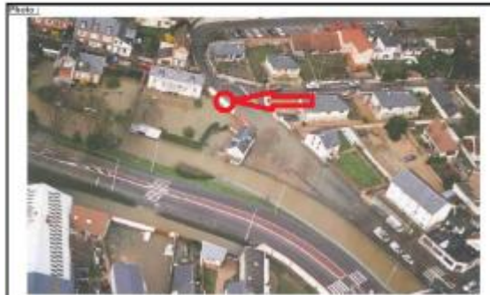
Vue aérienne pendant la crue.
