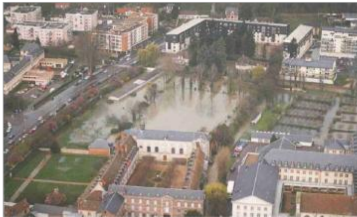
Vue aérienne lors de la crue.
