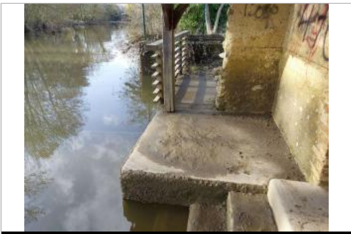
vue du lavoir côté Sarthe
