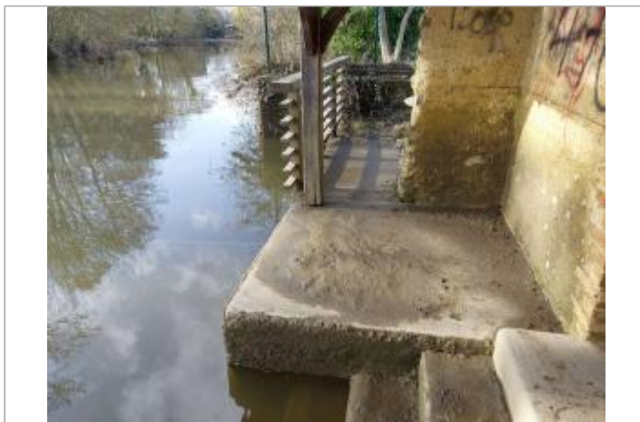
vue du lavoir côté Sarthe
