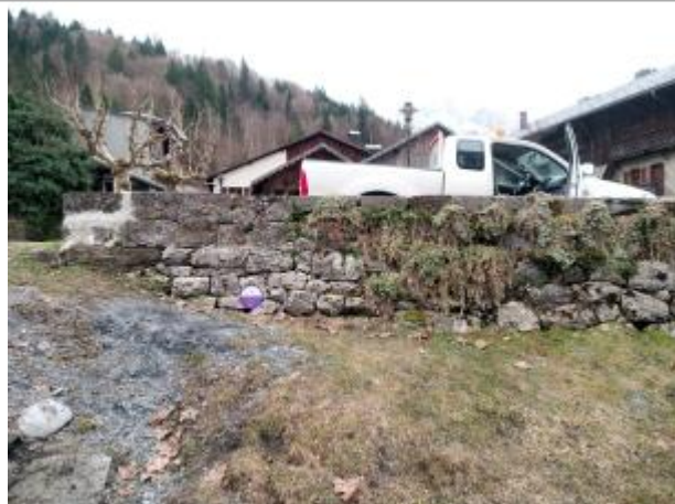
Mur aval pont de la mairie
