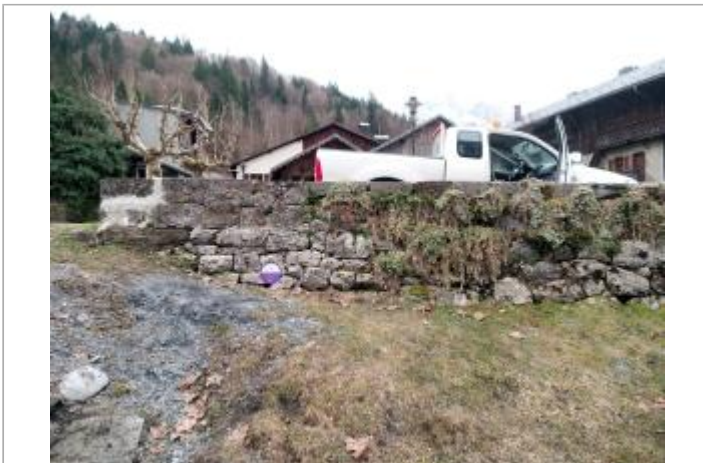
Mur aval pont de la mairie
