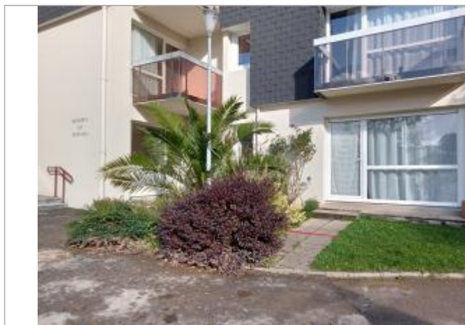
Laisse de crue au niveau de la 3 ème rangée de dalles.
