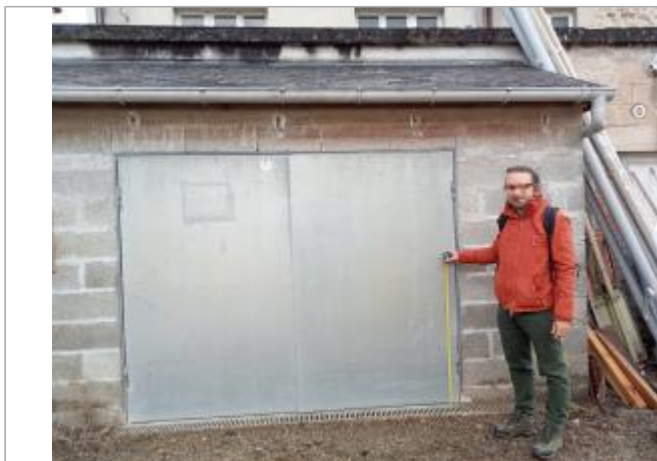
Prise de vue de la cour intérieure vers l'arrière du n°6
