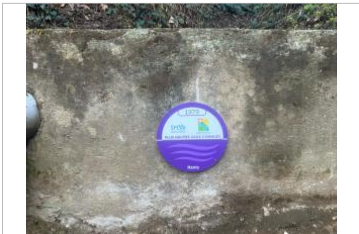
mur de béton du bassin
