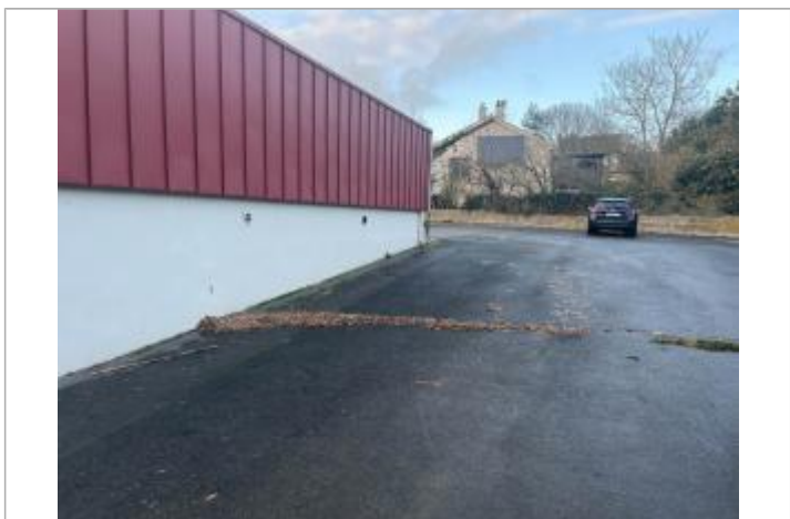
Crue du Lay Février 2026 - rue du Lay
