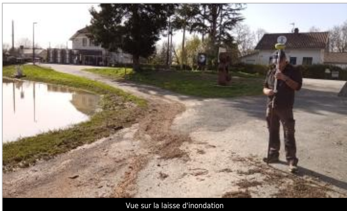
Vue sur la laisse d'inondation
