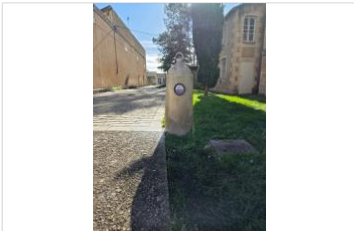
Repère CHAU03-R implanté sur une borne près de l'église
