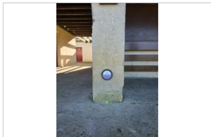
Repère installé sur bâtiment du stade de football
