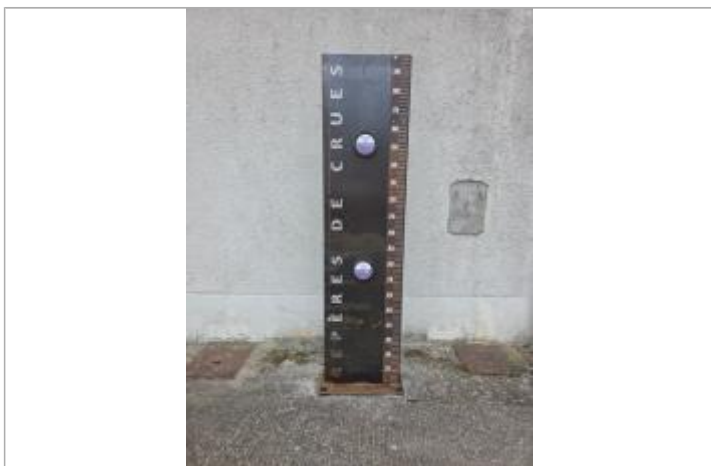
Repère BUXE01-R (en haut) et BUXE02-R installés sur un totem
