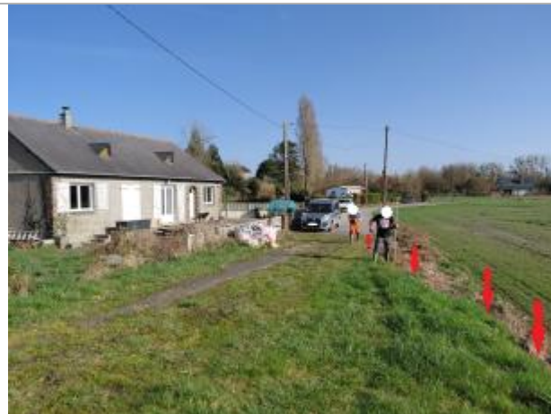
Vue depuis l'ancien passage à niveau.
