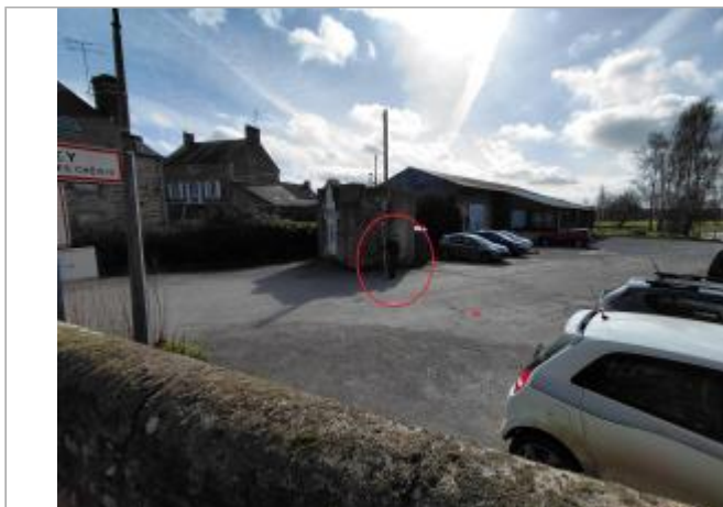
Vue depuis le pont.
