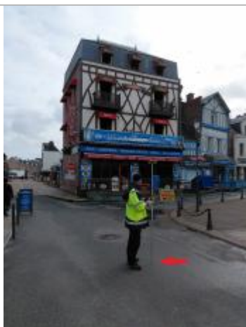
Laisse de mer à 10 cm/sol de la chaussée.
