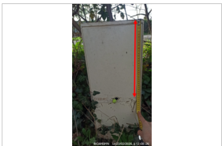
Dépôt de sédiments/végétation à 32cm depuis le dessus du poste ENEDIS
