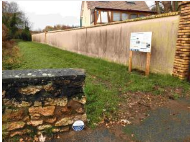
Repère de ruissellement du 31 mai 2016 à Ollainville
