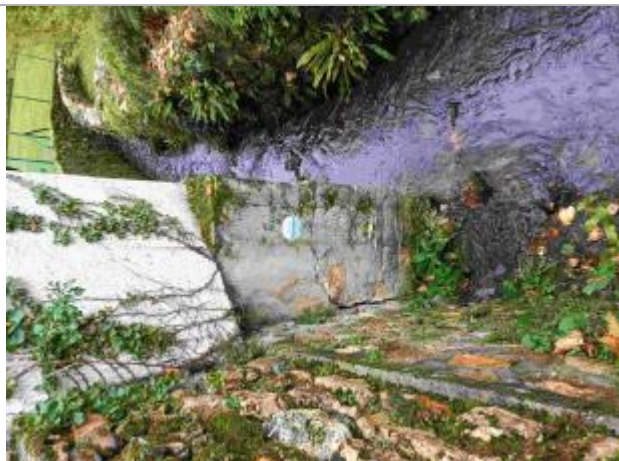
Repère de crue du 18 juin 2018 du Petit Muce à Forges les Bains
