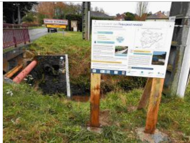
Repère de crue du 12 juin 2018 de la Prédecelle à Briis sous Forges
